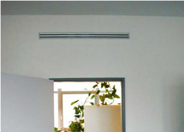
Einbaubeispiel Typ LDK-B zweischlitzig
