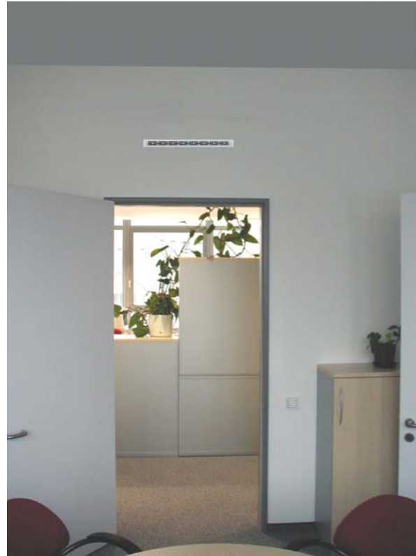
Einbaubeispiel Überström-Luftdurchlass Typ LDO-T
