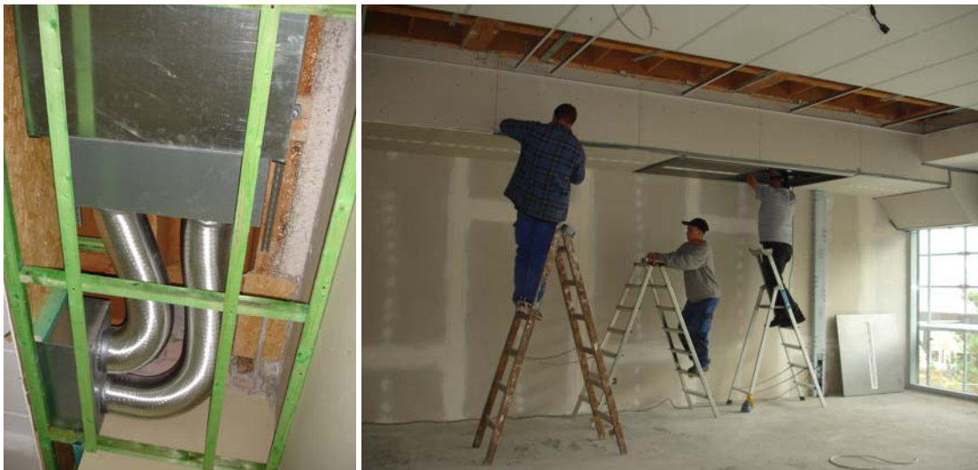
Unteransicht im Deckenkoffer mit Abluftdurchlass und Montagearbeiten
